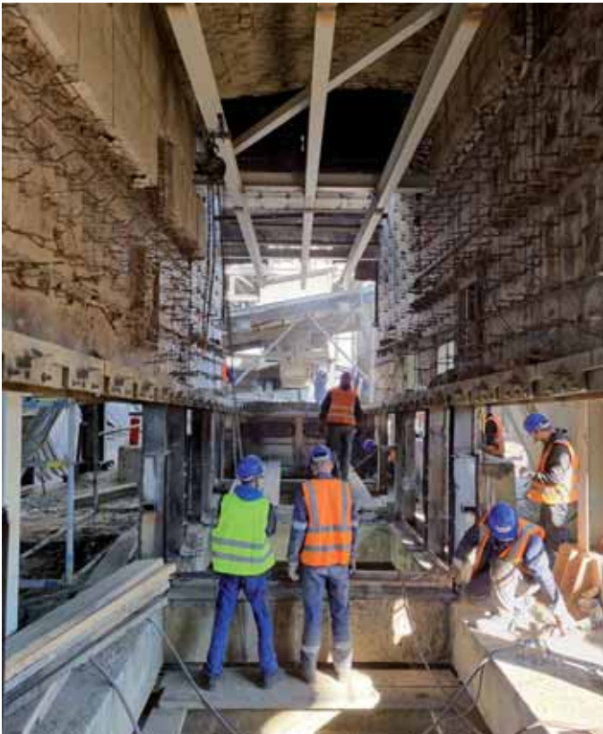
Rekonstrukcija hladnjaka klinkera i zamjena multiciklonskog otprašivača
